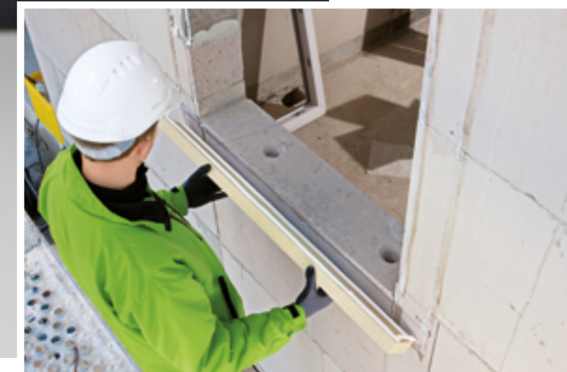
Az előfal rendszer profiljait biztonsági csavarokkal is rögzíteni kell, de a terhet kizárólag a ragasztó viseli.
