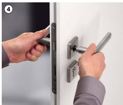
4 Kilincsek összedugása és az imbuszcavar meghúzása
