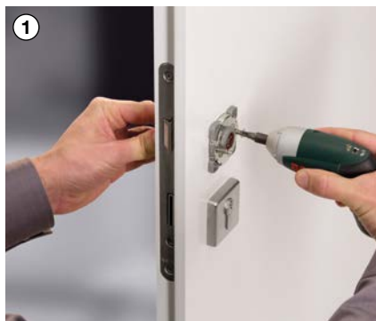
1 Alsó szerkezetek felhelyezése és felcsavarozása
